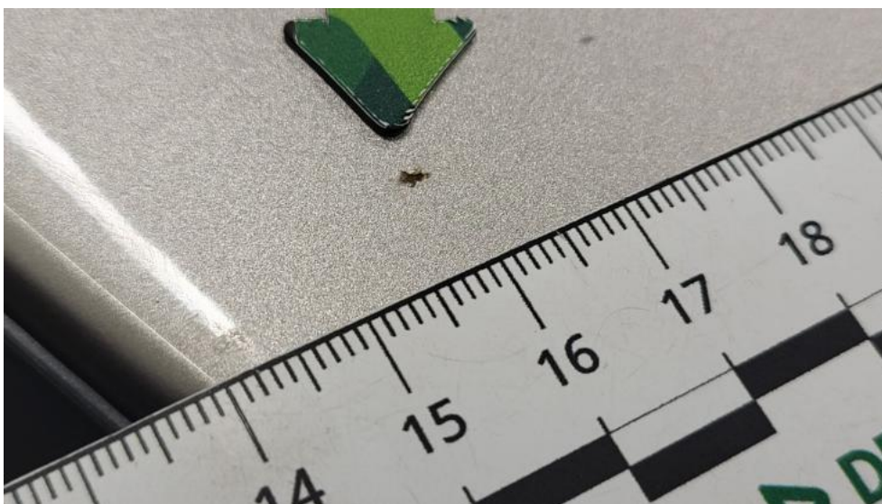
Fot. 54. Dach - Inne 1
