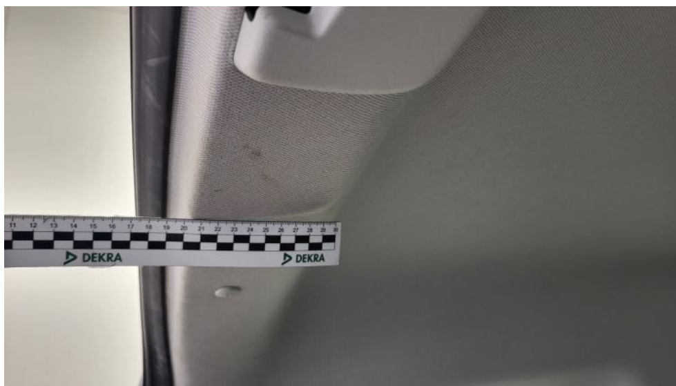
Fot. 81. Podsufitka - Inne 1
