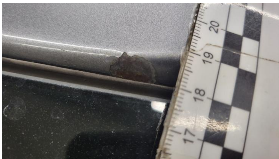
Fot. 62. Dach - Inne 1
