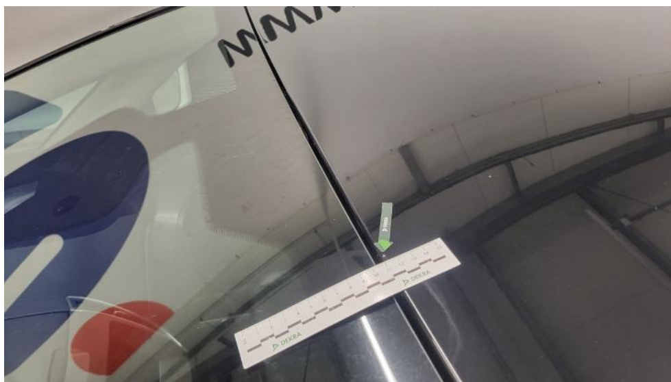
Fot. 74. Dach - zdjęcie poglądowe 1
