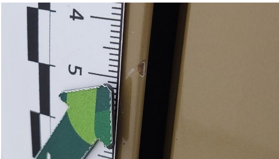
Fot. 59. Drzwi przed L - Inne 1
