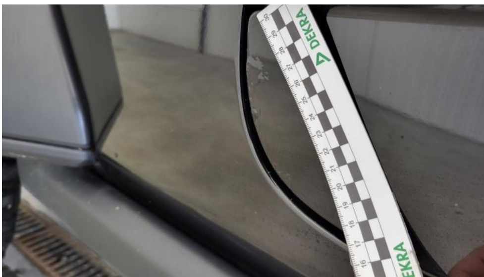
Fot. 53. Drzwi przed L - Inne 1
