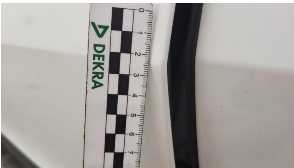
Fot. 63. Drzwi przed L - Rysa/odprysk 1
