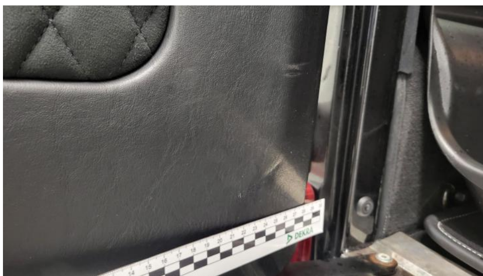
Fot. 92. Wykładzina pokrywy tylnej - Wgniecenie/odkształcenie 1
