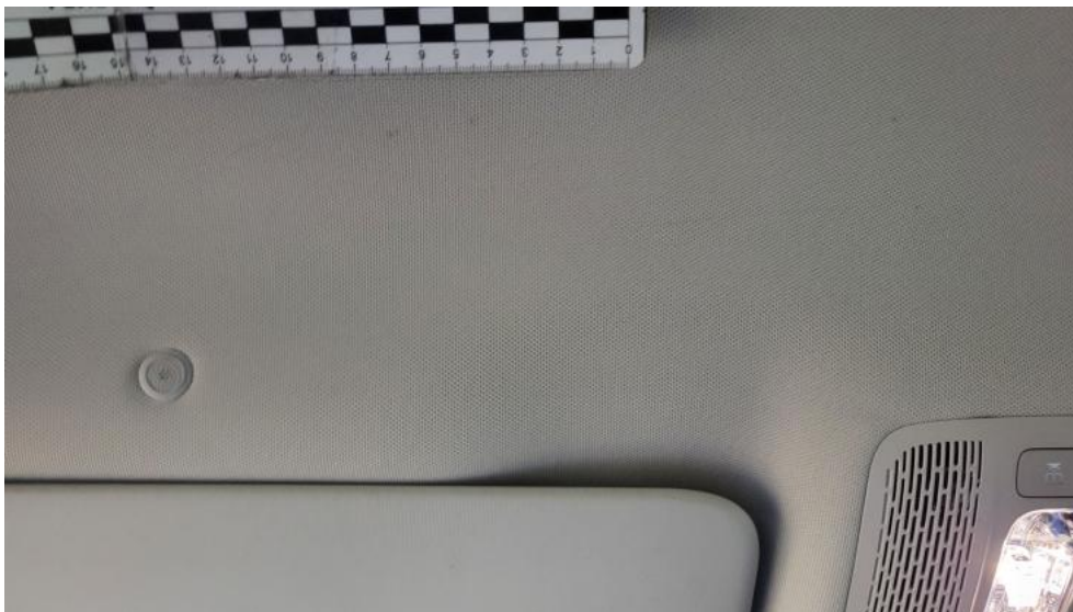
Fot. 59. Podsufitka - Inne 1
