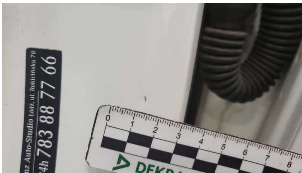
Fot. 57. Słupek środkowy L - Rysa/odprysk 1
