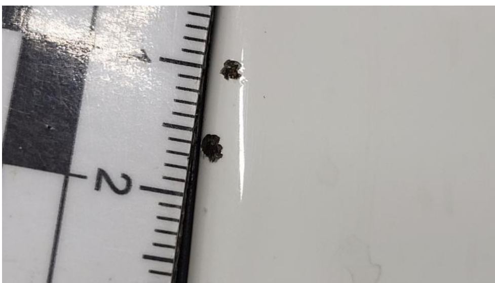
Fot. 56. Stupek przedni L - Rysa/odprysk 2
