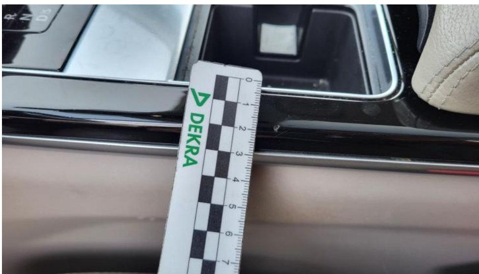
Fot. 56. Konsola tunelu śr. - Rysa/odprysk 1
