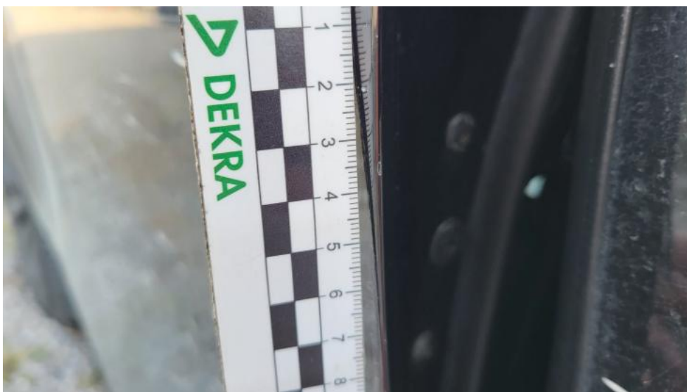
Fot. 52. Drzwi przed L - Rysa/odprysk 1
