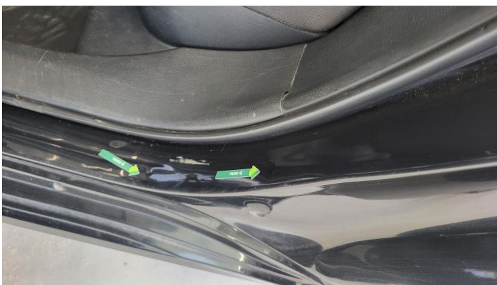
Fot. 86. Próg L - Wgniecenie/odkształcenie 1
