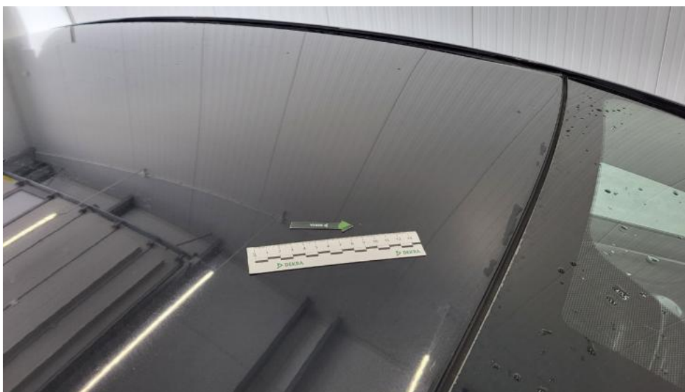
Fot. 61. Dach - zdjęcie poglądowe 1
