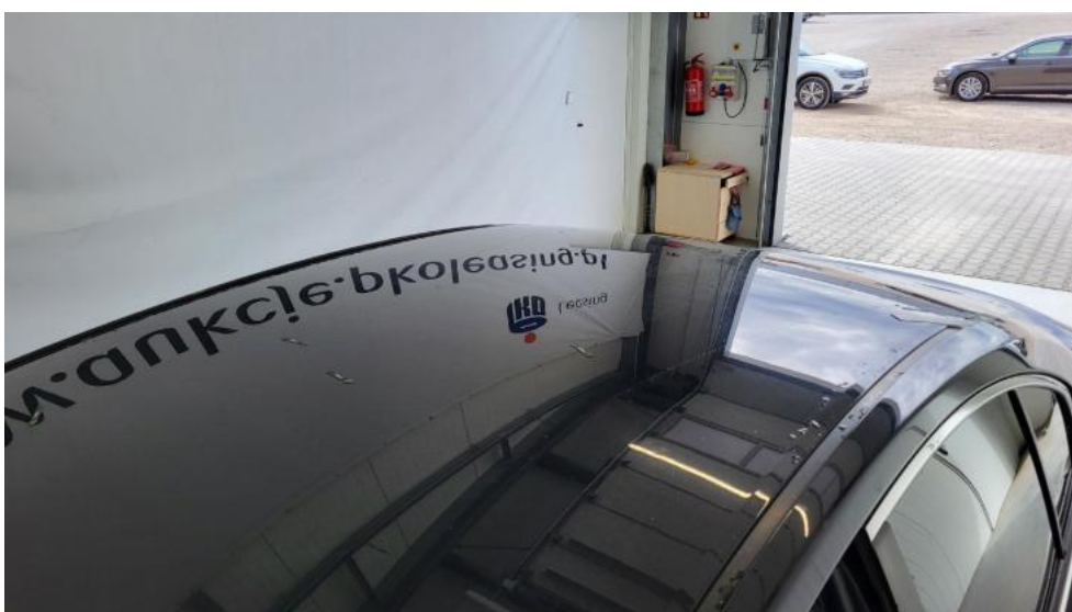
Fot. 62. Dach - zdjęcie poglądowe 2
