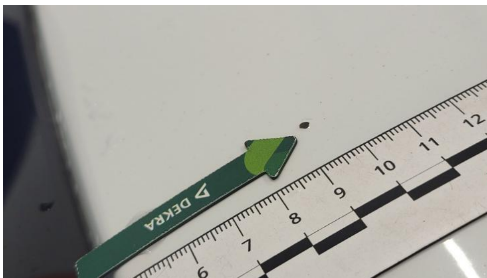
Fot. 87. Dach - Inne 2
