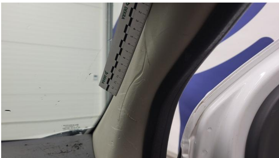
Fot. 128. Wykładzina(y) słupka przedniego P - Rysa/odprysk 1
