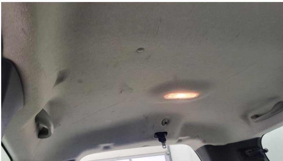
Fot. 127. Podsufitka - Inne 1
